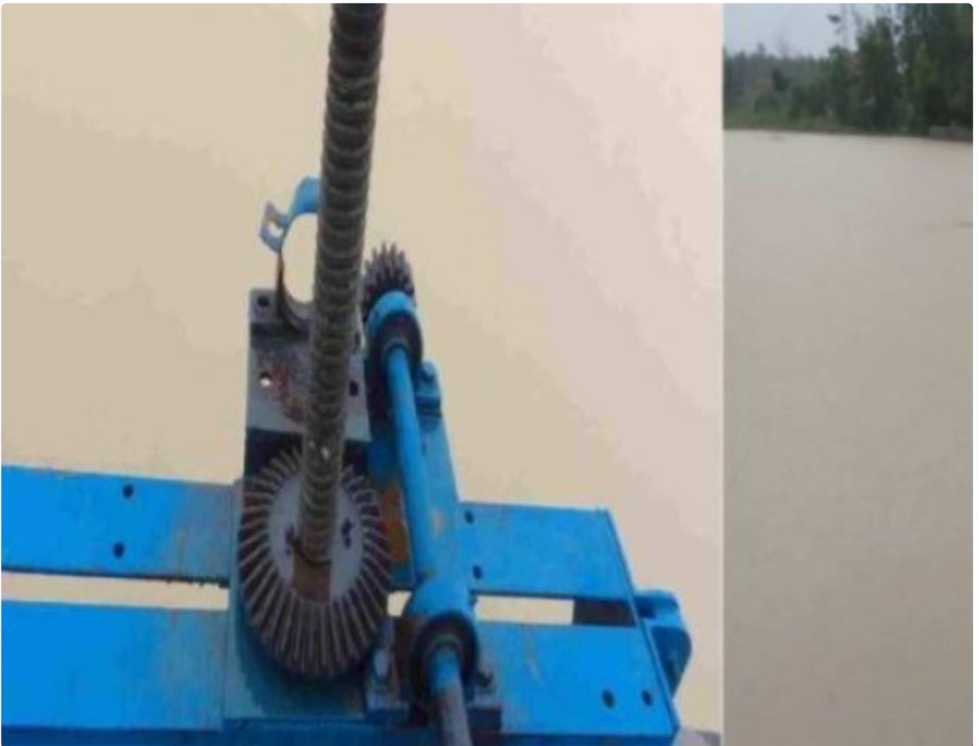
Pintu air Albaret Simpang Mesuji
